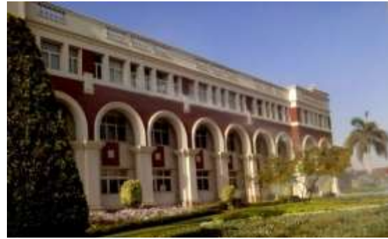
المصدر (المسح البصرى)
