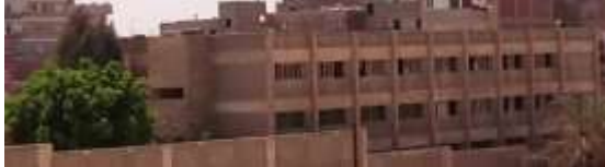
المصدر (المسح البصرى)
