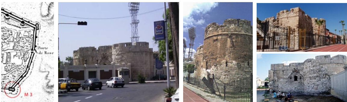
شكل (٢٠) أسوار الإسكندرية: برج الزاوية الجنوبي الشرقي (M3) المصادر: دراسة ميدانية للباحثة
