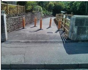
شكل (١٨) وضع الحواجز عند أماكن مرور المشاة مع إمكانية دمج الإضاءة مع الحواجز لتحسين الرؤية المصدر: (Rémillard-Boilard, Buffel, & Phillipson, 2020)
