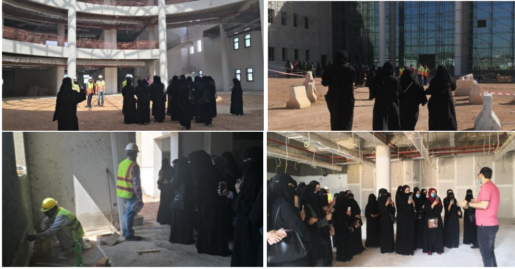
شكل (٧) صور من الزيارة الميدانية لمبنى كلية المجتمع جامعة طيبة - ٢٠٢٠م - المصدر: الباحث
