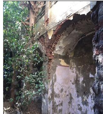
شكل (١٤) النظام الإنشائي المستخدم في الوكالة " الحوائط الحاملة والعقود والقبو"
