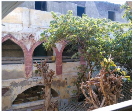
شكل (١٤) النظام الإنشائي المستخدم في الوكالة " الحوائط الحاملة والعقود والقبو"
