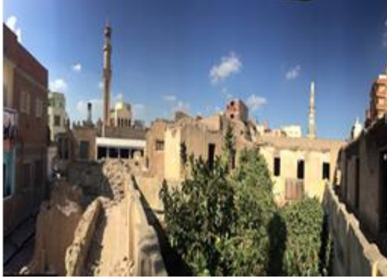
شكل (١٨) تصدع وانهيار أجزاء من الطابق الثالث
