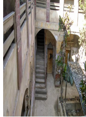
شكل (١٢) السلالم بعد تغييرها وتكسيثها بالموزايكو
