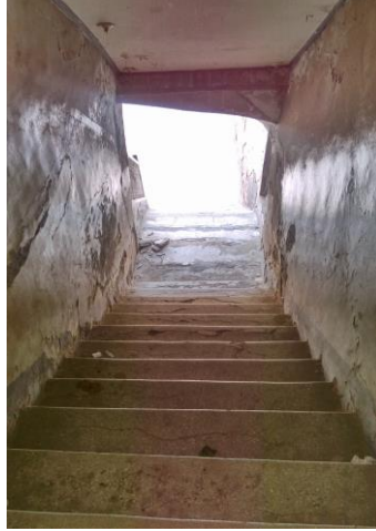
شكل (١٢) السلالم بعد تغييرها وتكسيثها بالموزايكو
