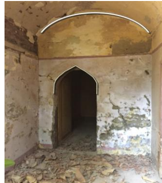
شكل (١٤) النظام الإنشائي المستخدم في الوكالة " الحوائط الحاملة والعقود والقبو"
